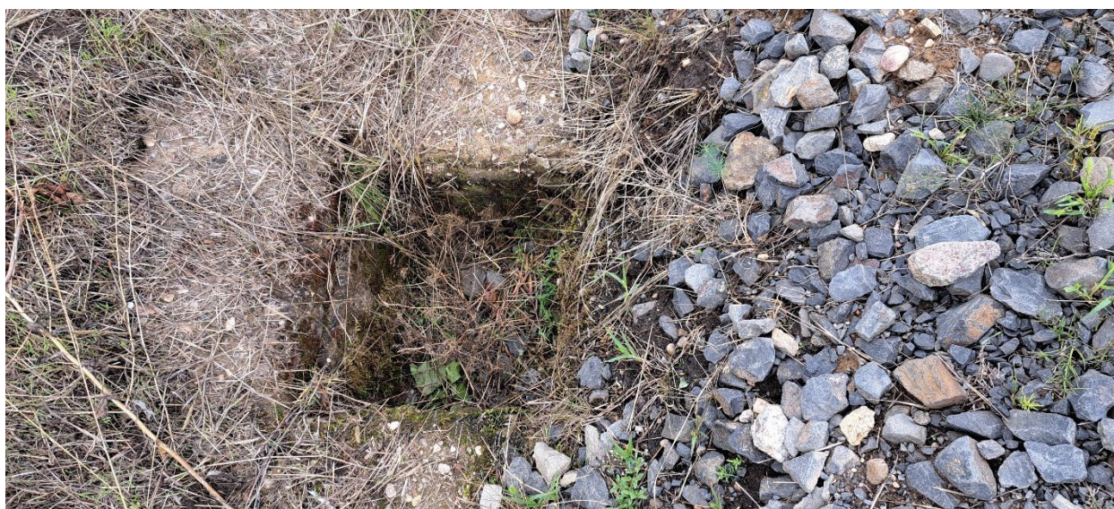
Obr. 2 Stávající zanešené šachtice směr Počeradské zhlaví
